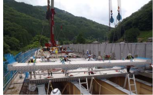
プレキャスト PC 床版架設状況
