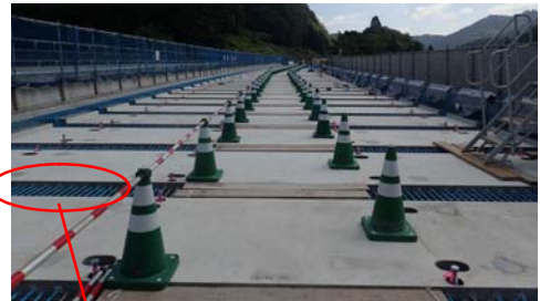
コンクリート床版取替え状況
