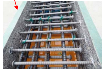
接合部の配筋状況
