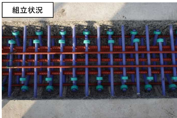
円形ナット:FCD450-10 エポキシ樹脂塗装:高付着型
